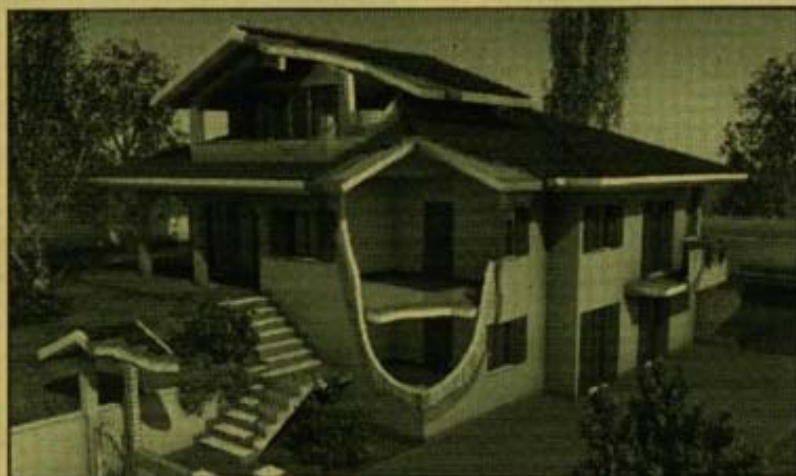
La casa costruita con i pannelli cerchiali di acciaio
