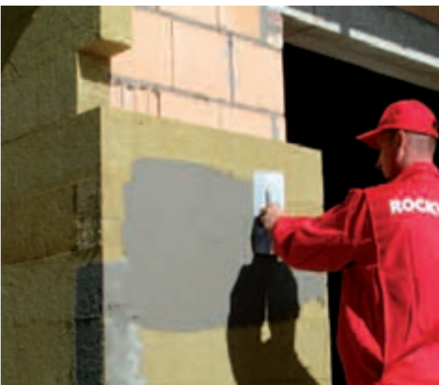
Esempio di cappotto realizzato con isolante fibroso.
