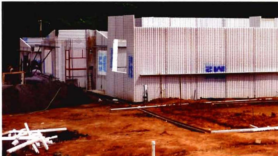
El sistema de paneles modulares prefabricados permite una construcción rápida, sencilla y limpia.
