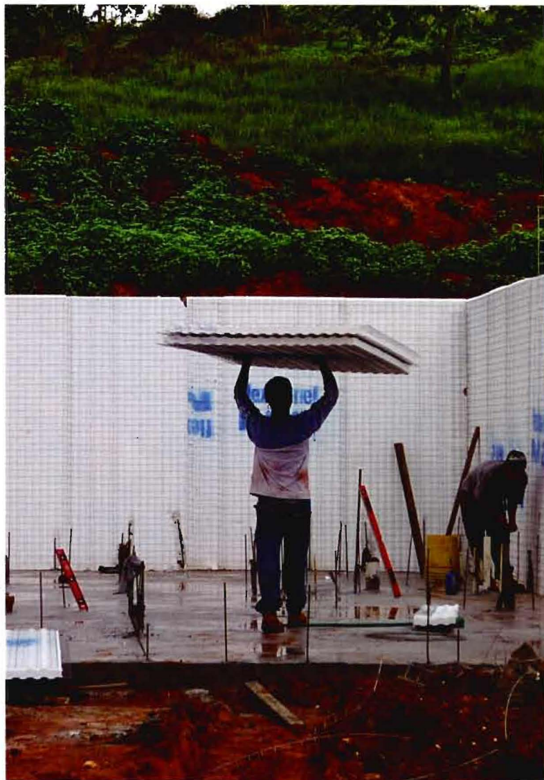
El sistema de paneles modulares prefabricados permite una construcción rápida, sencilla y limpia.
