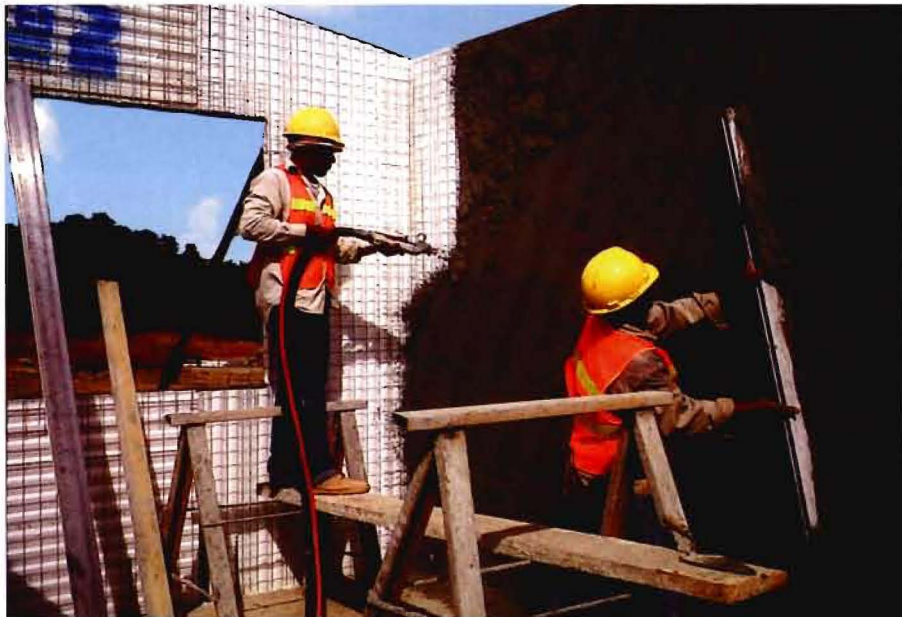
Las estructuras son altamente resistentes y protegen contra la humedad.
